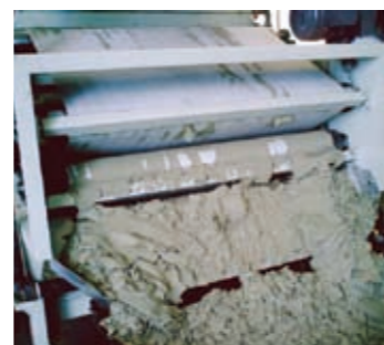
涂装废水(北京汽车制造厂) Spraying Sewage
