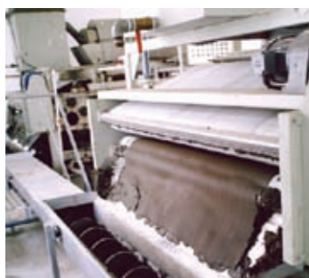
城市污水厂(北京良乡) Municipal Sewage
