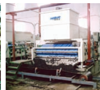
石材矿业废水(淮南谢桥煤矿) Mining & Stone Wastewater
